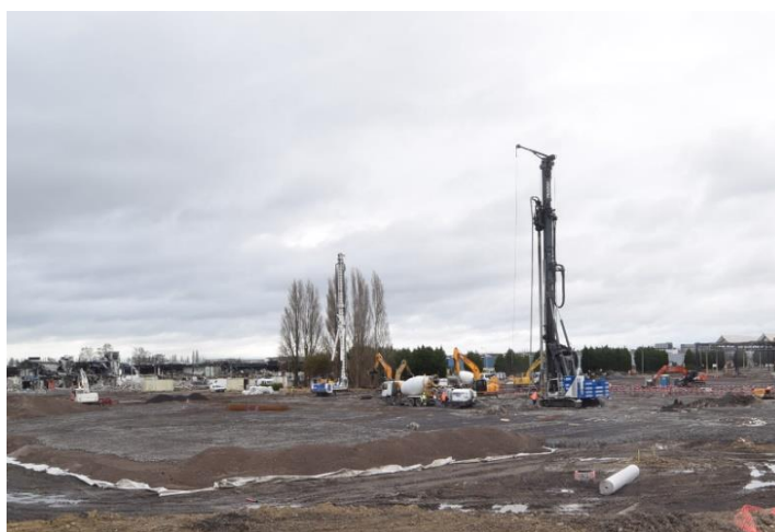
Préparation des pieux
