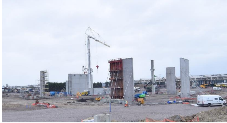
Elévation des premiers éléments de charpente
